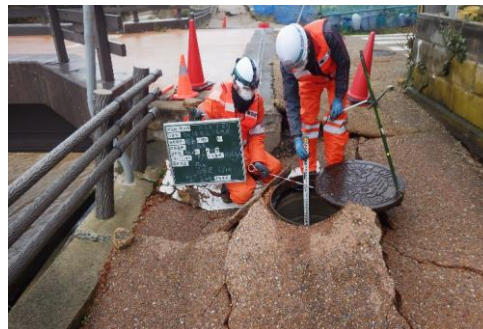
下水道管調査の様子
