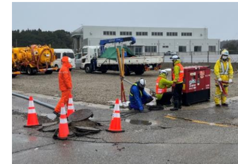
応急対応の様子（汚水溢水防止のための 水中ポンプによる水替え）
