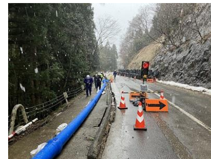
仮設配管の様子
