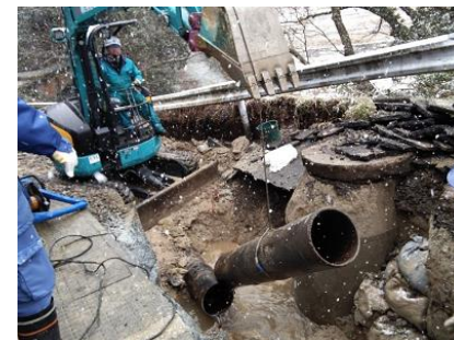
復旧作業の様子
