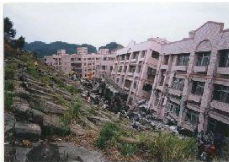
圖2-3-17 1997年溫妮颱風造成林肯大郡坡地崩塌災情 資料來源：工研院能資所-林肯大郡災變勘查報告
